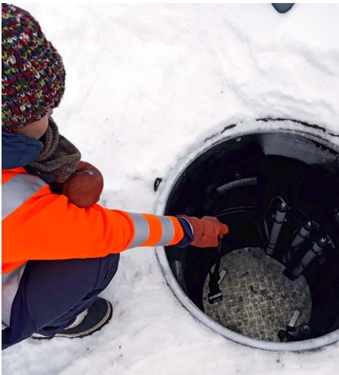
Hiedanrannan biosuodatin rakenteilla syksyllä 2018.
