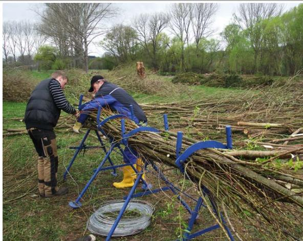
Fig. 97: Preparing a Living Fascine (source: Stowasserplan GmbH & Co. KG; stowasserplan.de)
